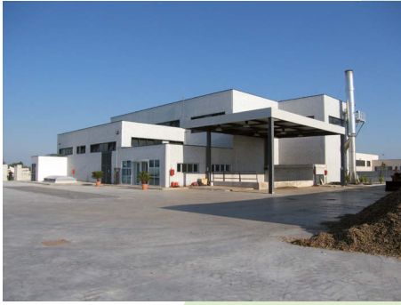
La sede operativa e centrale termica di Fiusis
